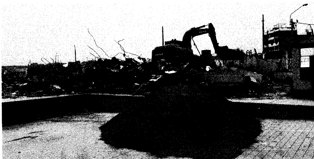
Foto n° 14: Acopio de demolición para la eliminación, con cuatro volquetes de 15 m3, una retroexcavadora y una excavadora.
