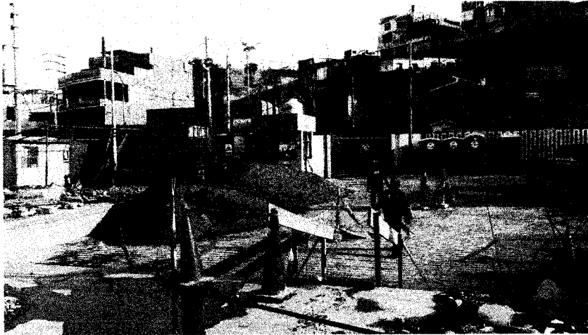
Foto n° 26: Señalización de seguridad temporal en los accesos a los frentes de trabajo.
